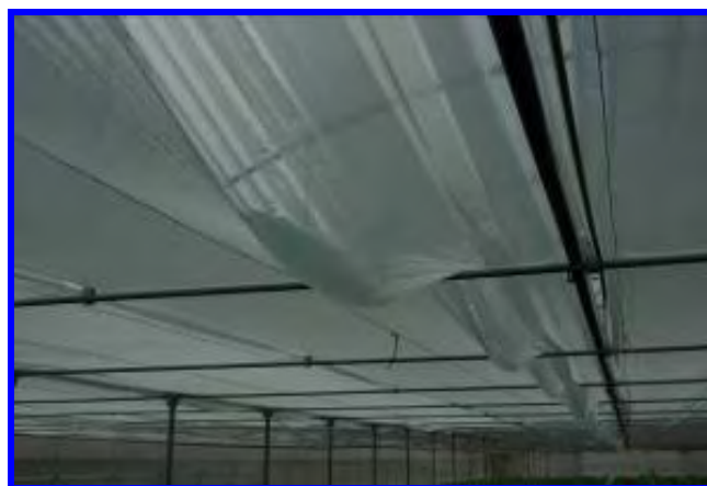
particolare di una sacca di acqua accumulata per effetto dell'umidità dell'aria.
