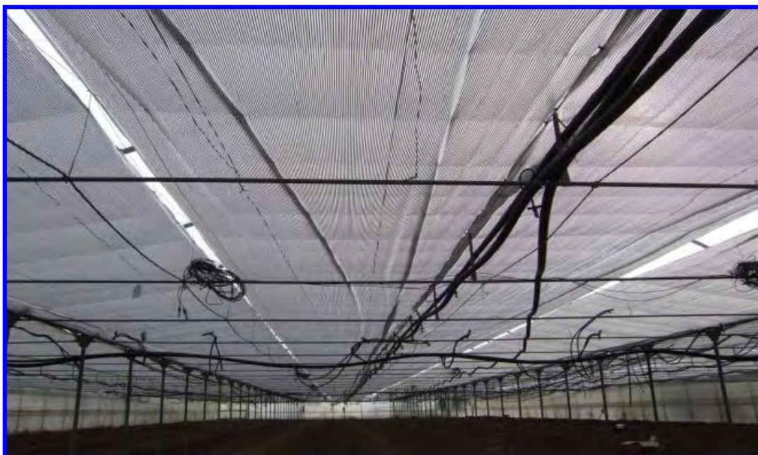
Una visione degli schermi termici distesi sull'orditura dei cavetti che li sorreggono.
