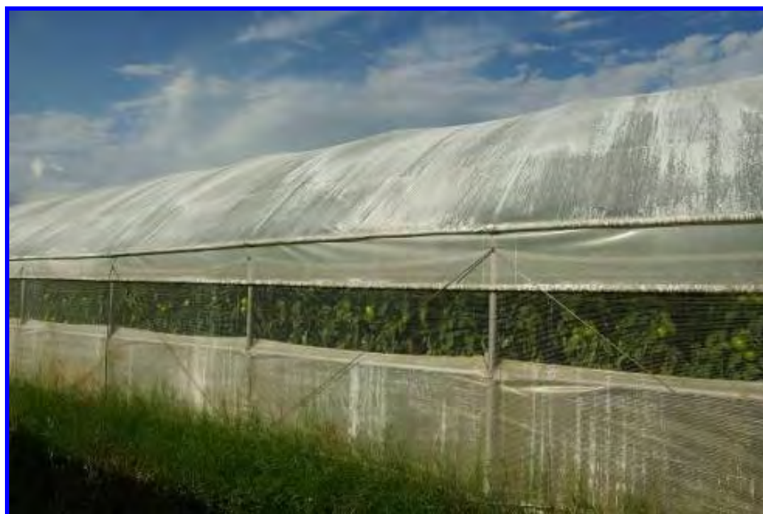
Copertura trattata con latte di calce, pratica resa necessaria per limitare l'eccessivo irraggiamento solare estivo che provoca elevate temperature dell'aria, con conseguenze sulla qualità del polline e danni per fisiopatie ai frutti (scottature).
